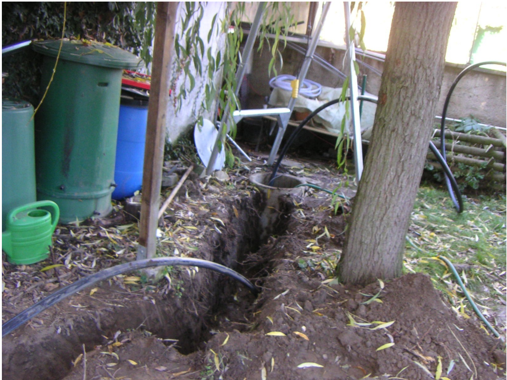
„Einfädeln“ des PE-Rohres in das Schluckbrunnenhaus
